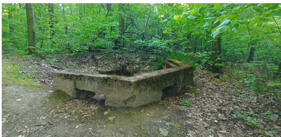
Jeden z dochovaných pozorovacích bunkrů v lese nad krematoriem (souřadnice: 50.0635625N, 14.3299906E). (Foto: Tereza Štefanová)
