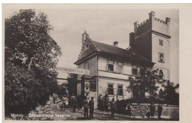
Kasárna 101. dělostřeleckého pluku na historické pohlednici.
