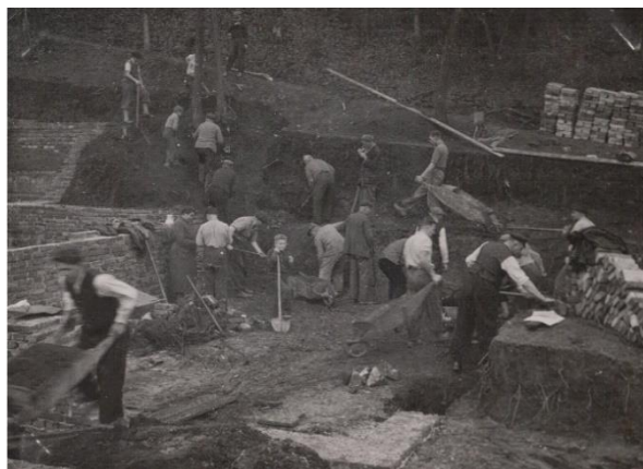
Hloubení základů sokolovny v létě 1939. (Foto: Archiv Sokola Motol)
